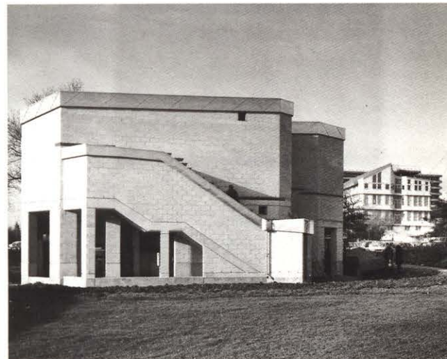
Primer plano de la fachada este, con el Edificio 6 Este atravesando la 'explanada' al fondo. Close up view of the east-face, with Building 6 East across the 'forecourt' in the background.
